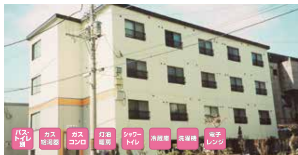
[取引態様仲介] 1988年12月建築(2004年改)/鉄骨4階建/28㎡/全15室
